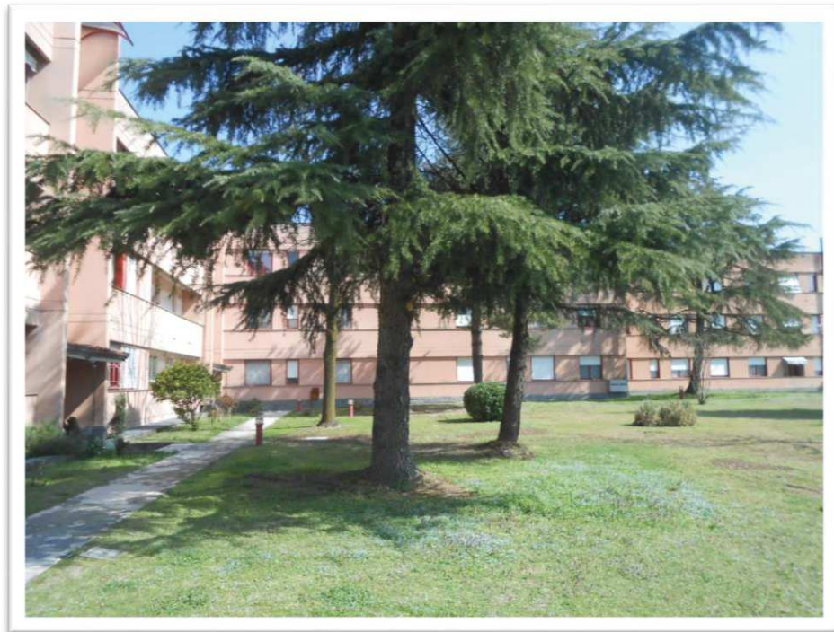
Foto 3 vista del giardino condominiale
