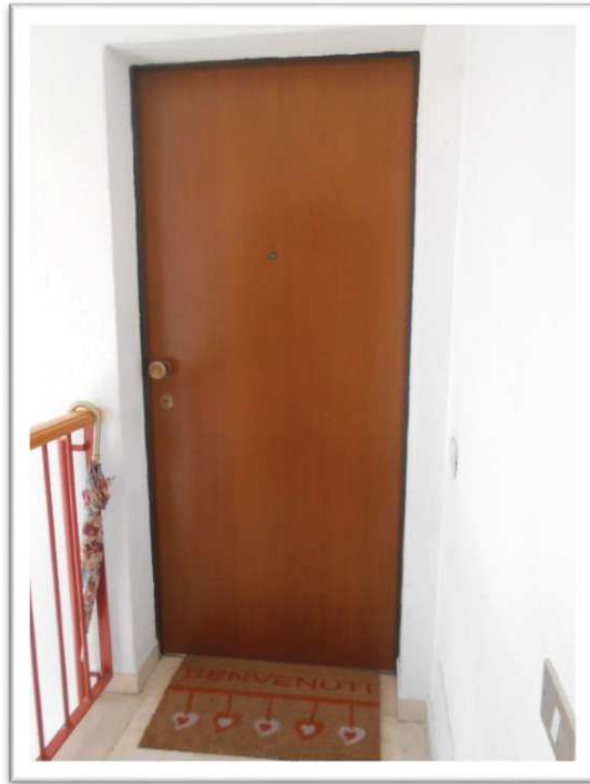
Foto 6 porta ingresso all'immobile
